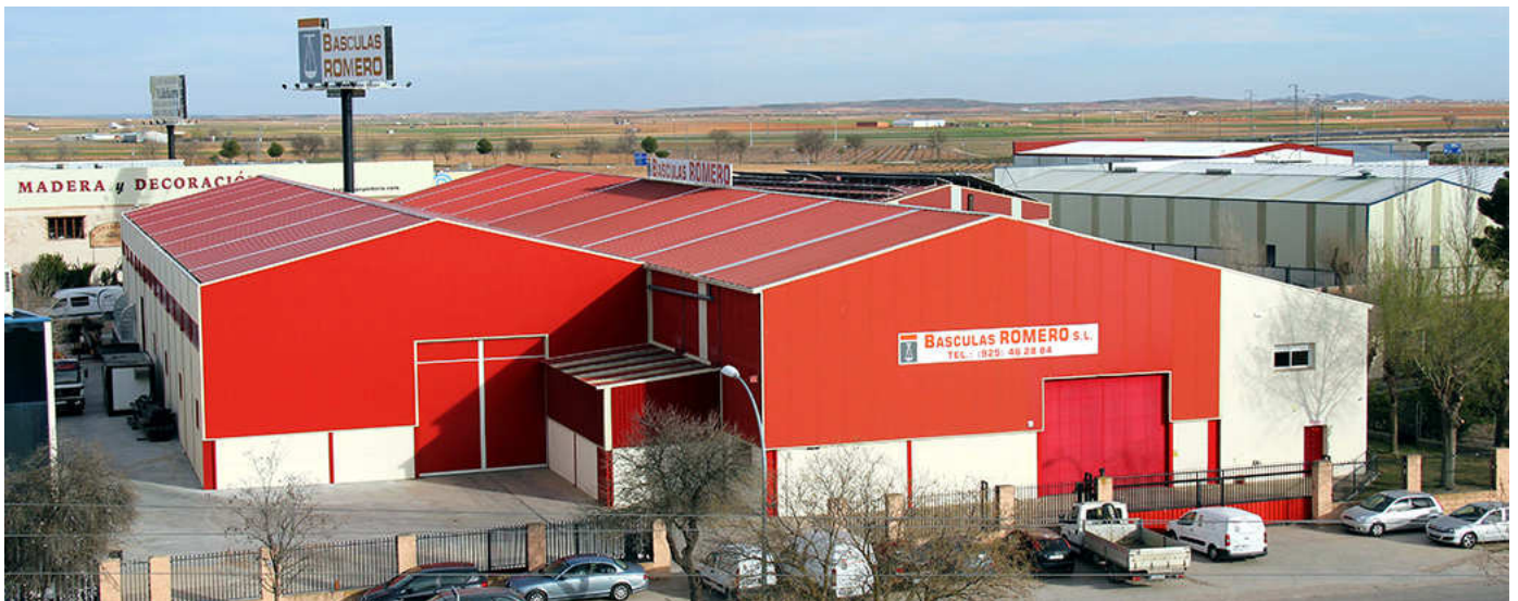
Vista de la nave
